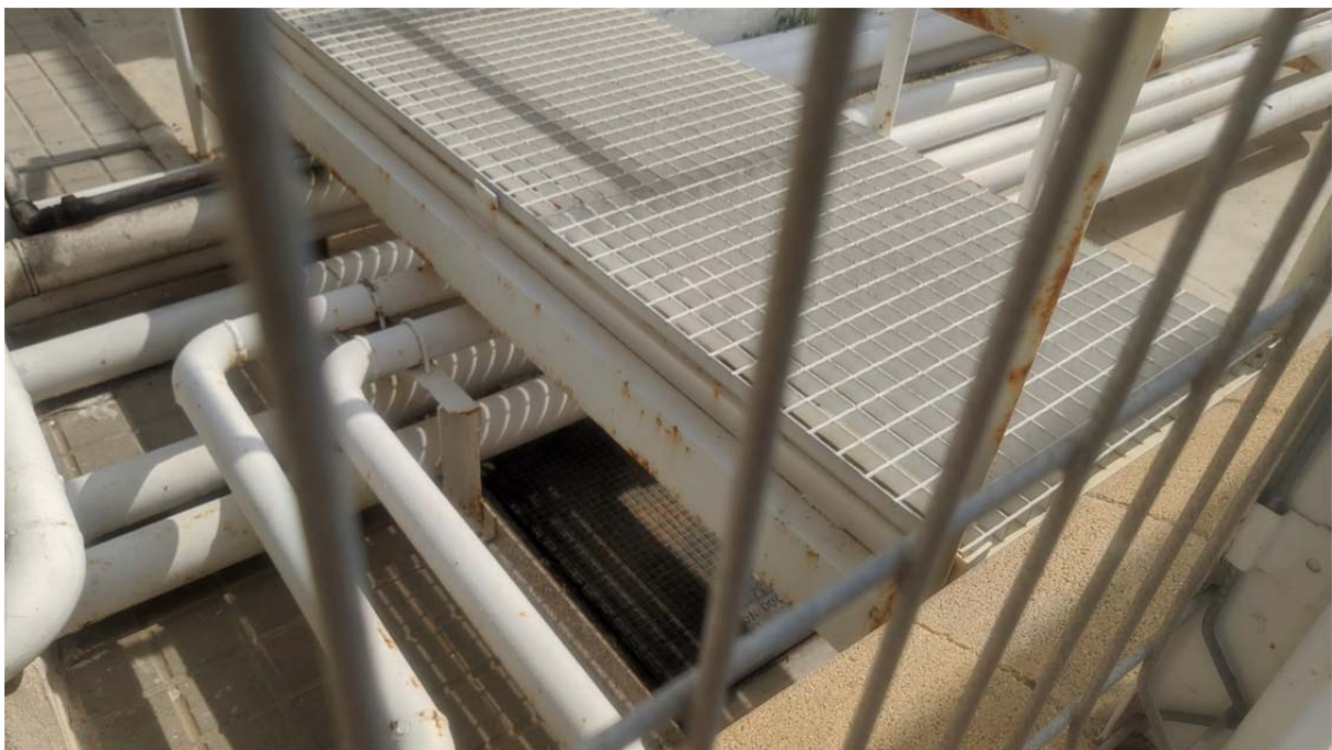
Arqueta de conexión en el interior de la gasolinera.
