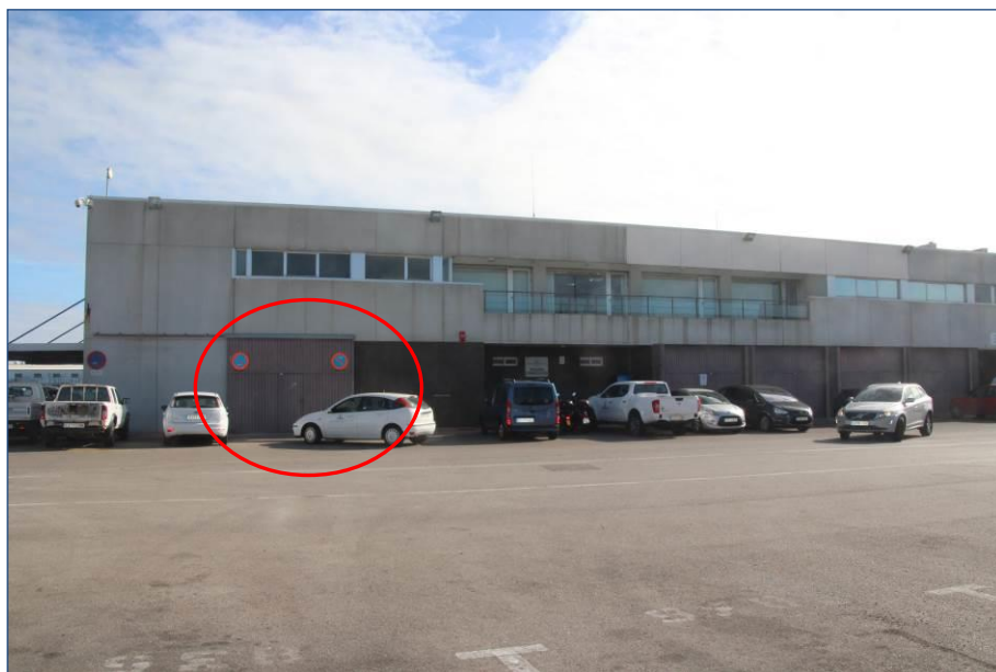
Almacén de Seguridad y Medio Ambiente de la APBC
