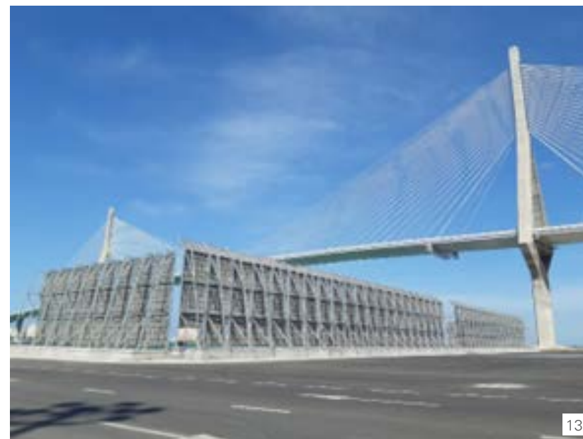
13. Desde agosto de 2020, las antiguas pantallas se han visto sustituidas por una nueva configuración que cuenta con 233 metros lineales, y su altura asciende a los 14 metros.
