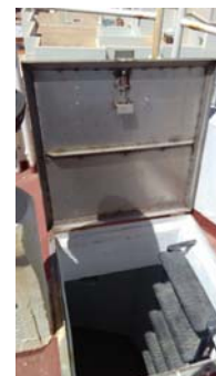
Vista de trampilla en Faro de Barbate
