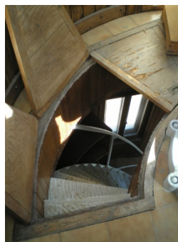
Vista de trampilla en Faro de Cádiz
