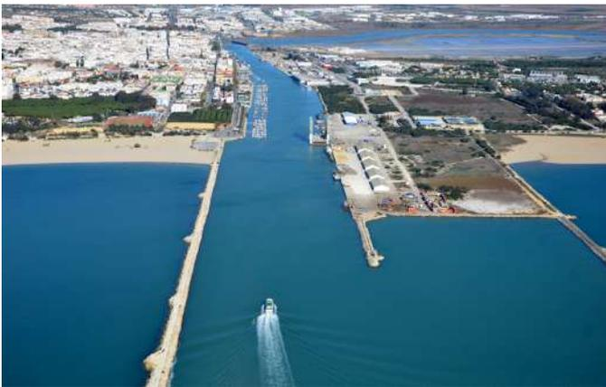
La Instalación Portuaria de El Puerto de Santa María desarrolla un importante papel como gracias a su destacada actividad pesquera. El muelle exterior cuenta con servicio de grúas y almacenes. Se ha retirado la rampa ro-ro para la instalación de una rampa fija y foso destinada al izado de embarcaciones de recreo para su invernaje.
