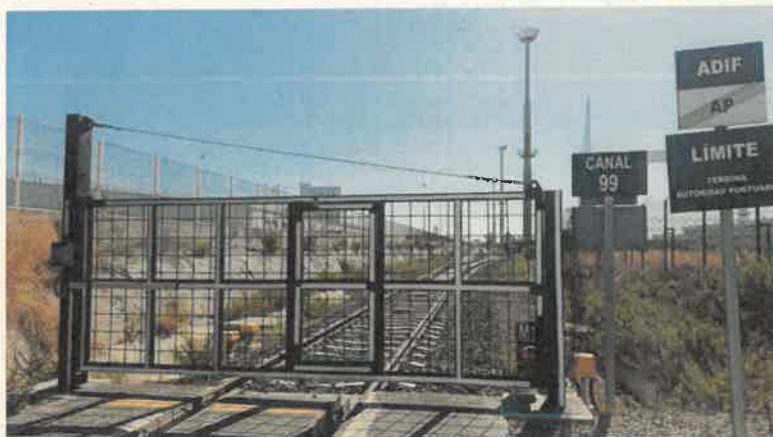
Punto de conexión físico y funcional. Vista desde el puerto. Puerta de salida.
