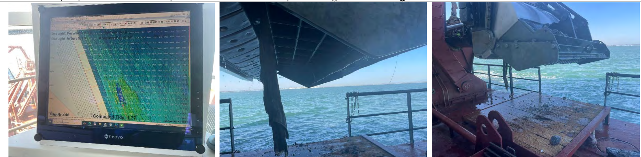
Figuras 07: Monitor del multihaz con la zona de dragado, las profundidades y la posición de la draga en la zona frente de cajones de la NTC. Tras la primera carga. Figura 08 y 09. Supervisión del cabezal al finalizar la primera carga. Resultado negativo.
