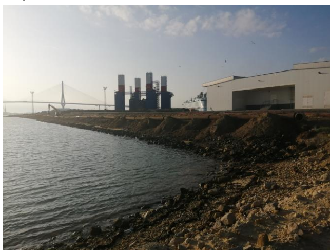
Instalación tubería del 25/10/24
